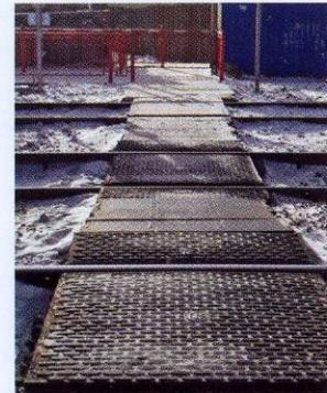
Настилы обладают противоскользящей поверхностью и обеспечивают безопасность перехода в любую погоду. Переходите железнодорожную дорогу только по настилу, иначе Вы рискуете запнуться за рельсы или оступиться на щебне или шпалах.
